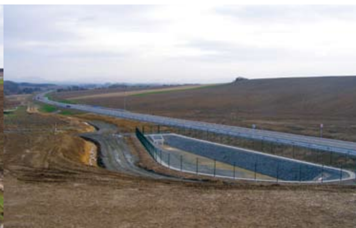
Retenční nádrž podél hlavní trasy přeložky silnice I/57
