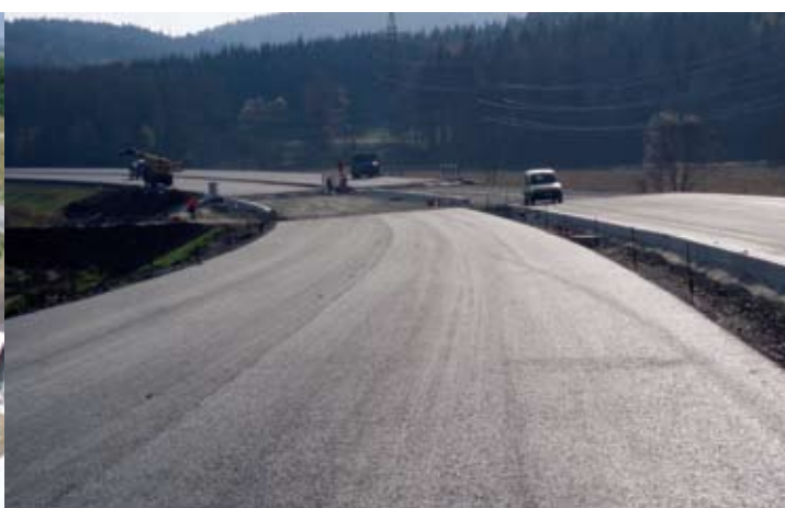
Mōst přō vodotěč v km 9,320 na silnici I/57, smř Vsetřn
