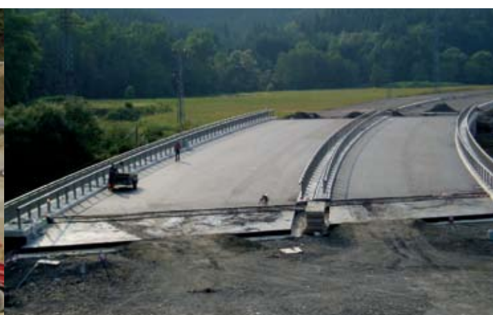
Mōst na silnici I/57 přō Bečvu v km 9,792, smř Valašskē Mezřřřči
