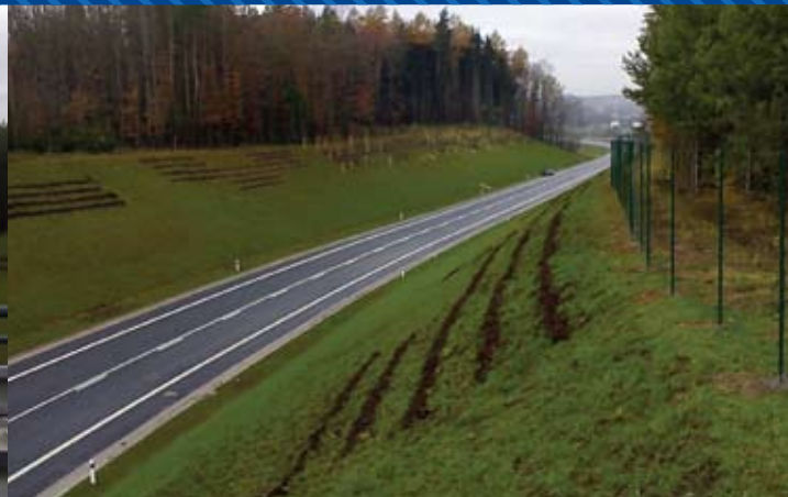
Pohled do zářezu, km 2,500
