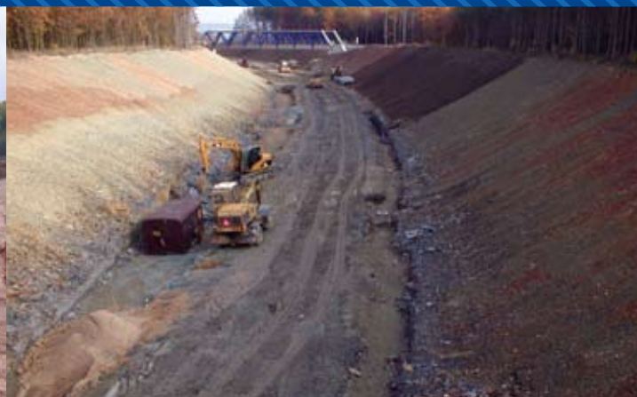
Pohled na výstavbu v zářezu, km 3,500
