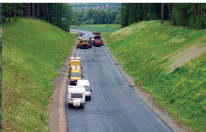
Pokládka obrusných kobců, km 2,500
