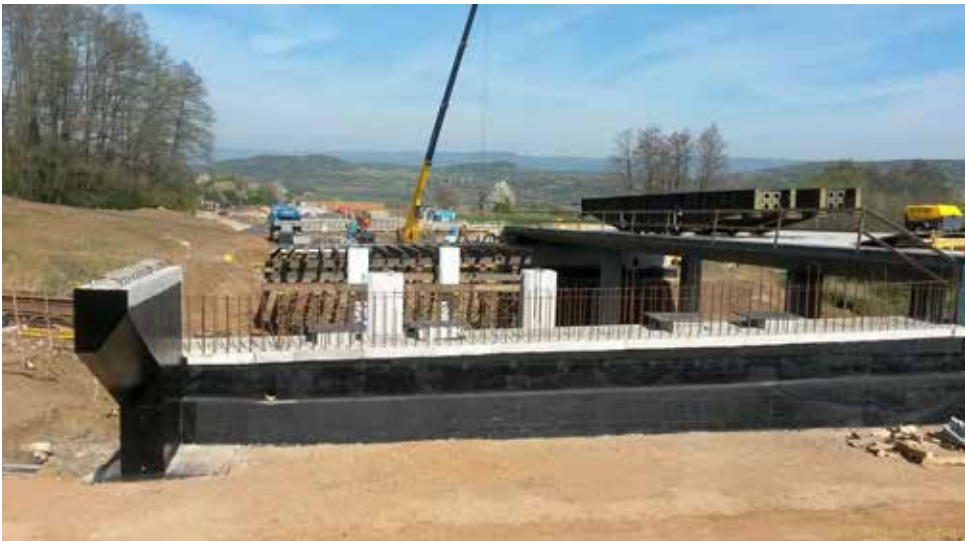
Dálnice D8 Lovosice–Řehlovice
